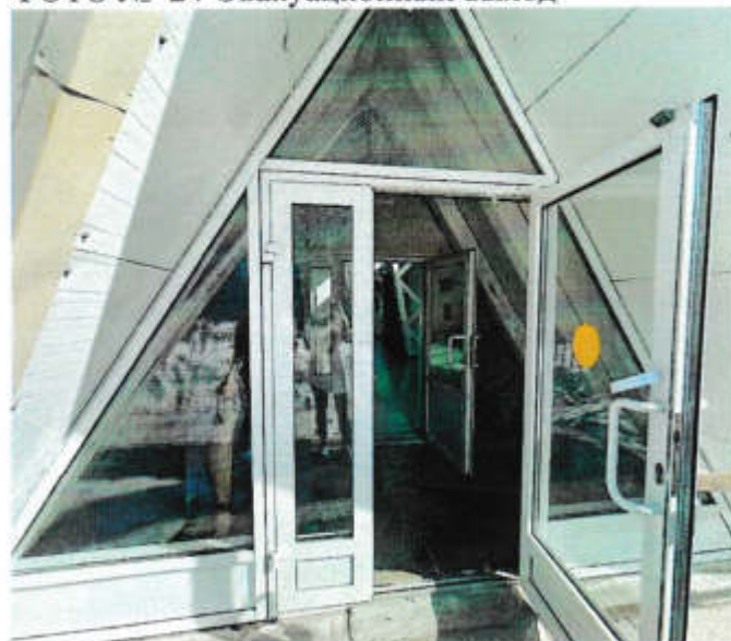
ФОТО № 24 Эвакуационный выход
