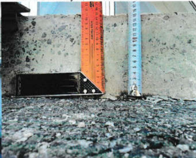
ФОТО № 32 Эвакуационный выход
