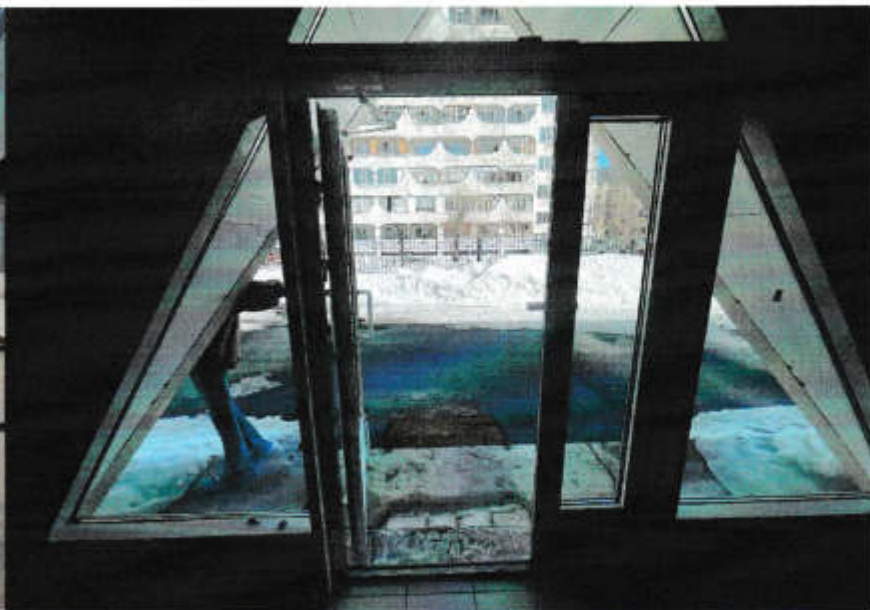
ФОТО № 30 Эвакуационный выход
