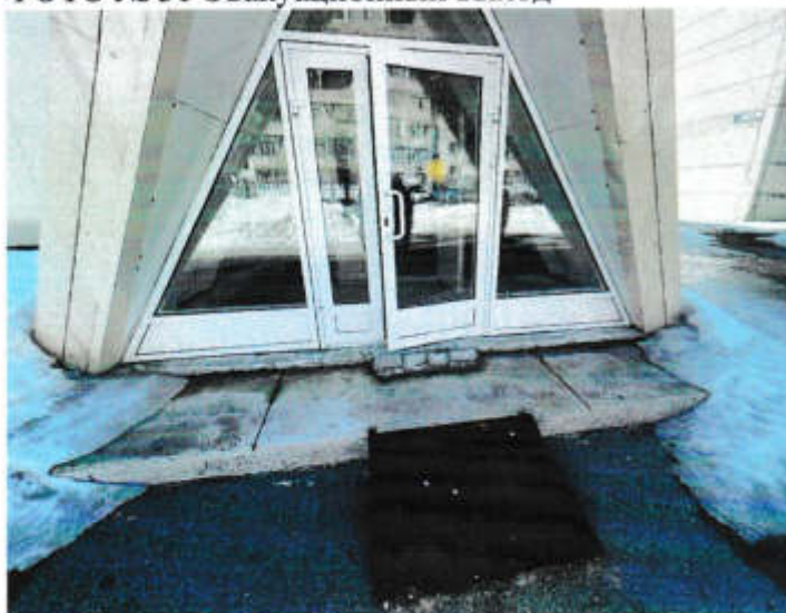
ФОТО № 31 Эвакуационный выход
