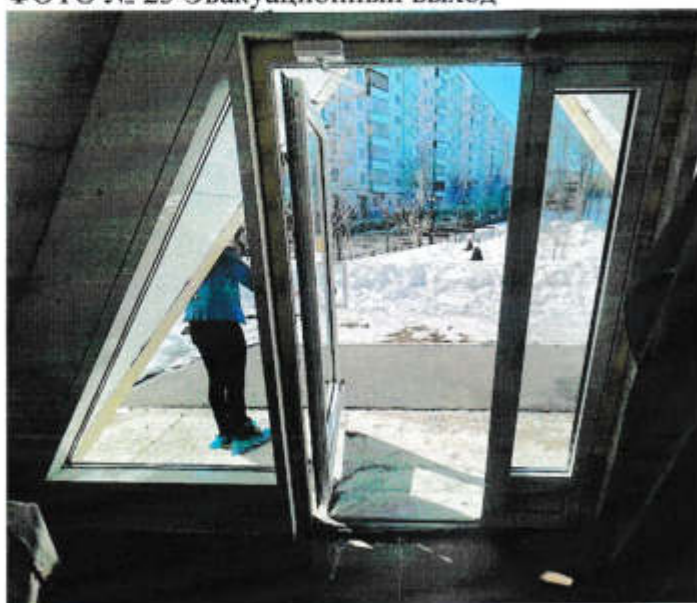
ФОТО № 23 Эвакуационный выход
